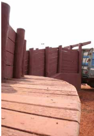
VISTA DE LA PASARELA DE TRABAJO AL COSTADO DEL EMBARCADERO.
