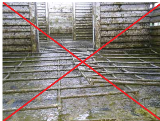
CAMIÓN CON PISO TORCIDO Y DAÑADO
