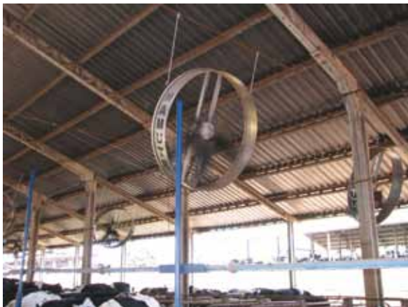
SISTEMA DE VENTILAÇÃO NO FREE-STALL
